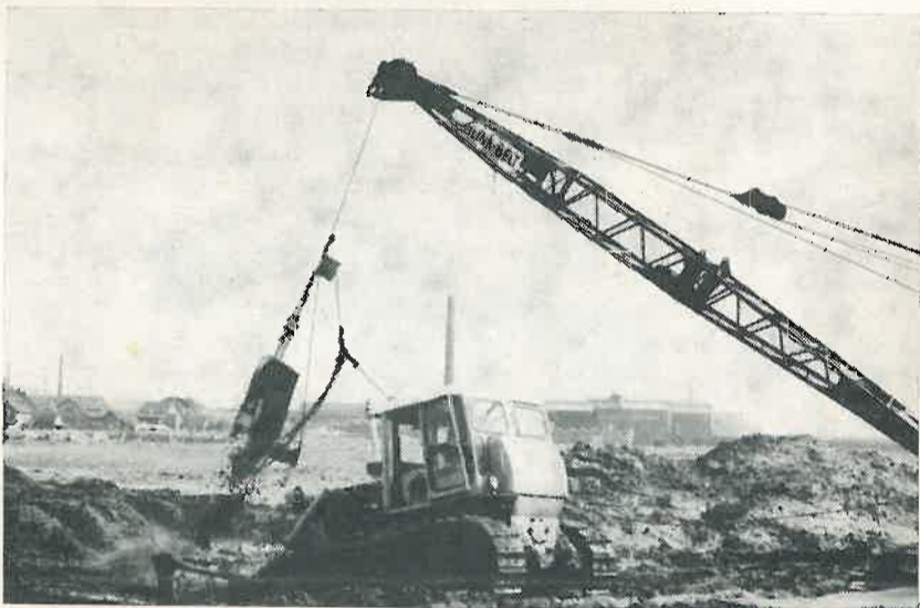
De 26-tons dragline bijt grommend in het zand en werpt de baggerspecie voor de oersterke bulldozer.
